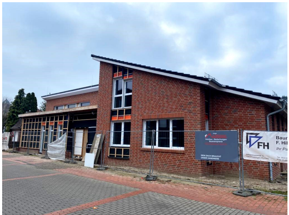
Noch Baustelle - die neue Kindertagesstätte in der Mühlenstraße, in der ab Sommer 2023 zwei zusätzliche Gruppen Platz finden werden.
